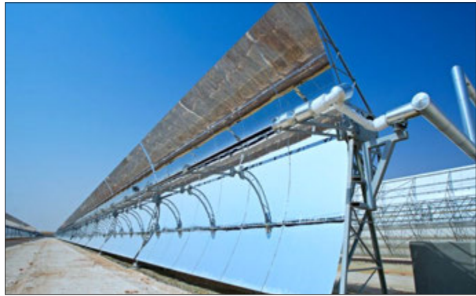
شکل شماره ۴. تصویری از یک نیروگاه خورشیدی متمرکز
